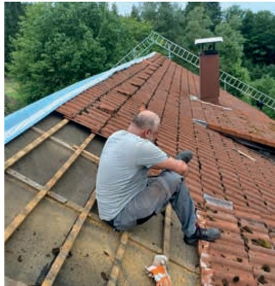
Dach weitergehen konnte. Es musste die Dachlattung und Teerpappe entfernt werden. An einigen Stellen war das Holz der Dachlattung komplett weggefault und die Teerpappe durchlöchert, was auch den Wassereintritt in einige Zimmer erklärte.
