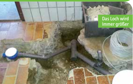
Eine weitere Toilette
